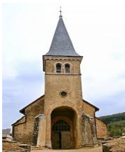
Église Saint Etienne de Châtel à Gizia (F. Michel, architecte du Patrimoine -2017)
