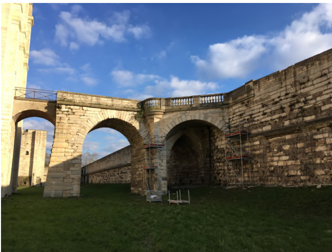
Tour du Bois du château de Vincennes (OPPIC, 2BDM - 2018)
