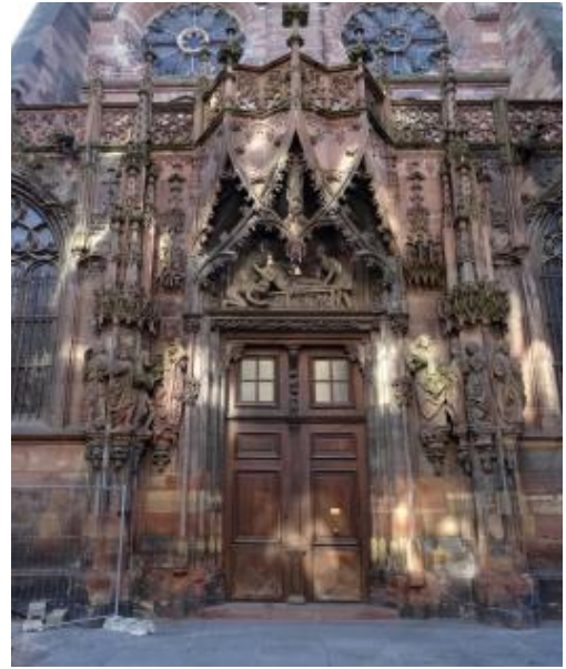
Cathédrale de Strasbourg - Analyses des pierres, mortiers, sels solubles, et polychromies sur le chantier du Portail Saint Laurent (Œuvre Notre Dame, Ville de Strasbourg - 2021 en cours)
