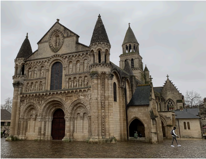
Église Notre-Dame-la-Grande de Poitiers Diagnostique intérieur (Frédéric Didier ACMH - 2BDM, Ville de Poitiers - 2021 en cours)
