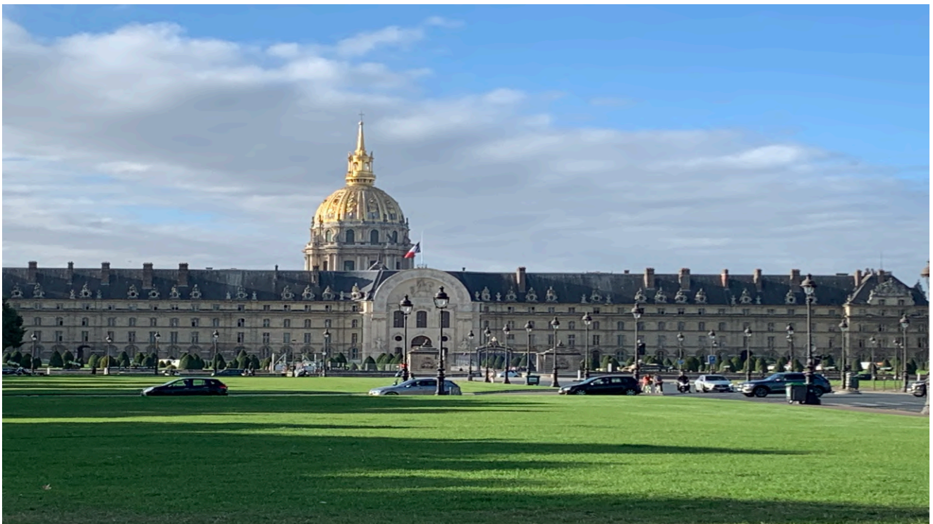
Chantier de restauration de la façade Nord de l'Hôtel des Invalides, Paris 75 Contrôle laboratoire Lot 9 : pierre, mortier, protocoles de restauration OPPIC - Atelier Cairn (P. Barnoud - ACMH) (en cours 2021-2024)
