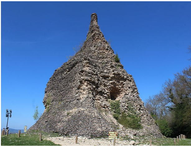
Pyramide de Couhard à Autun (Fabien Palisse, architecte du Patrimoine - 2020)
