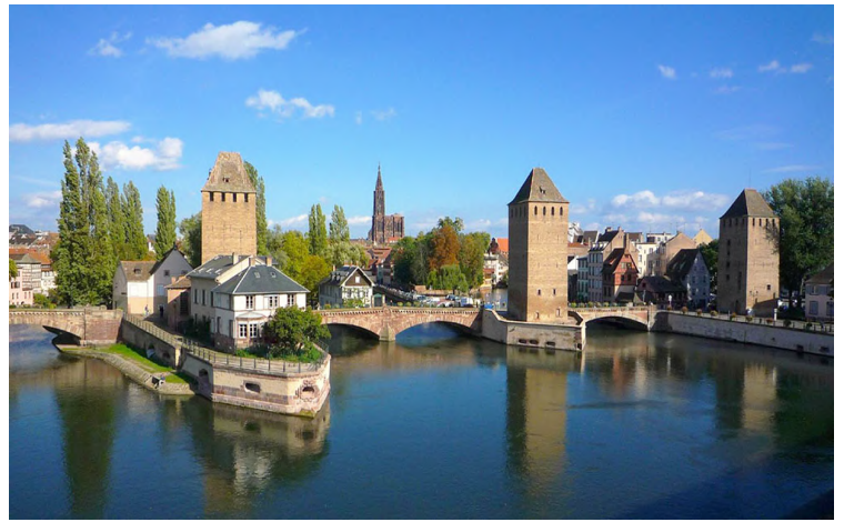
Tours Altheim, Heinrich, des Français et du Bourreau des Ponts Couverts à Strasbourg (Ville de Strasbourg - 2020 et 2018)
